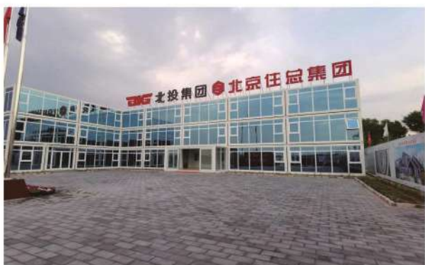
北京北投集团新建项目
